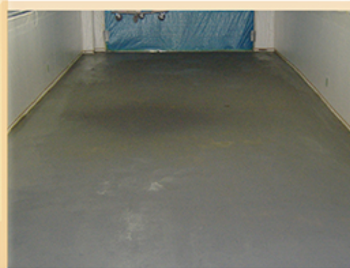
③ P-II施工(ローラーで塗布) →
