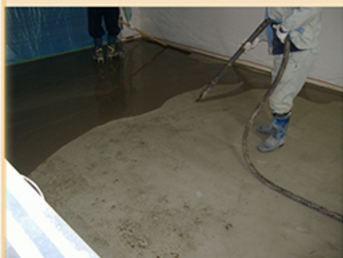
④ SL材施工 →
