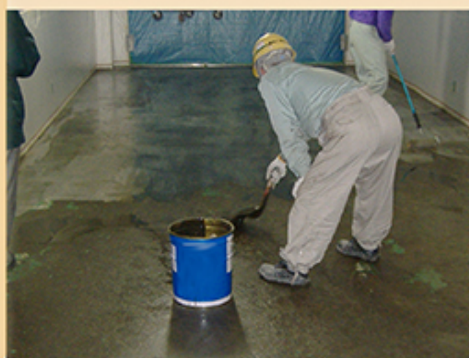
② オイルタック施工(ローラーで塗布) →
