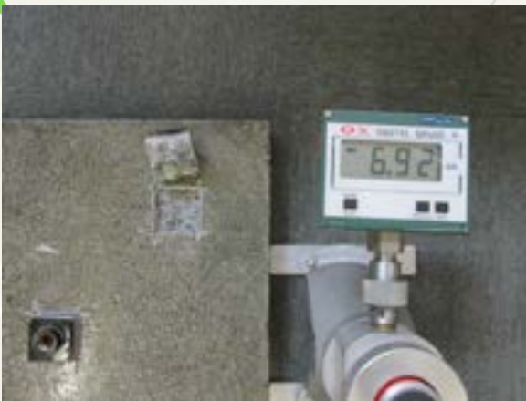
全体に見える黒い部分は水分がある箇所です
