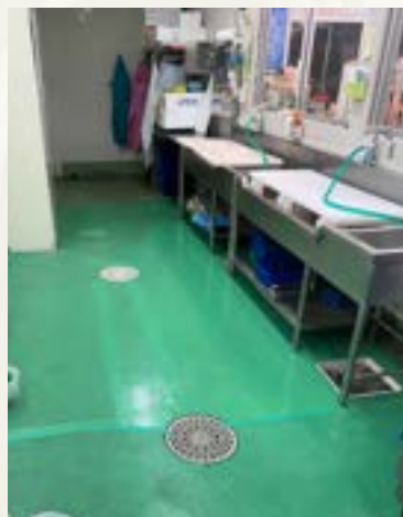
水性2液性ポリウレタン塗料で仕上げ
