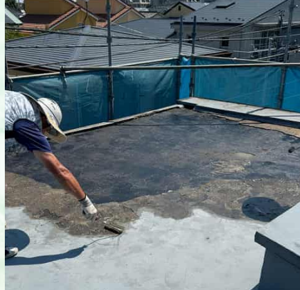
フェルコンS-Ⅱを施工
