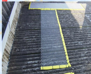
踏み抜き防止とフルハーネスで しっかり安全対策をします
