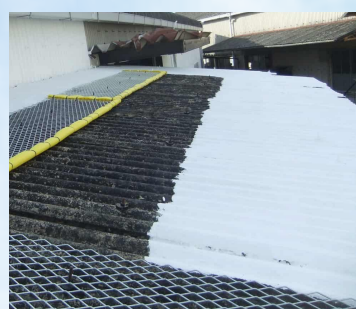
断護をウールローラーで施工 (エアレスやハケでも可能)
